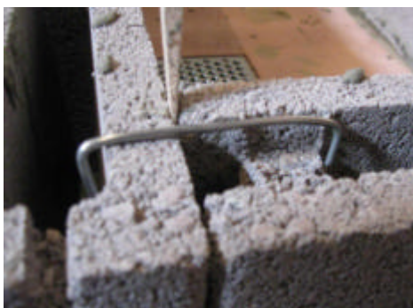
LilaTec-Steine mit Hafnerdraht verbinden.
