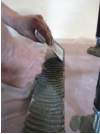
Haftmörtel Kontaktschicht für die erste LilaTec-Steinreihe mit einer Zahnpachtel auftragen.
