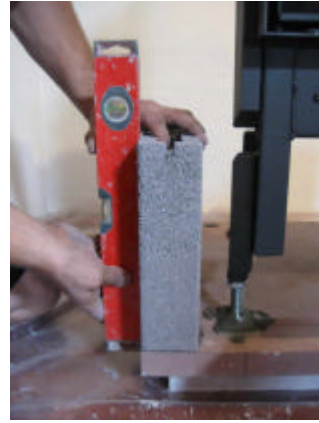
LilaTec-Steine nach Verlegeplan aufstellen.
