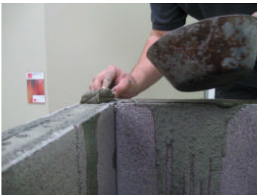
Eine Haftmörtel-Kontaktschicht für die Deckelplatten auftragen.
