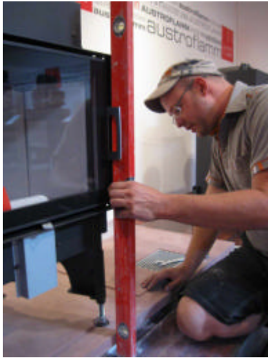
Kamineinsatz mittels Wasserwaage ausrichten.
