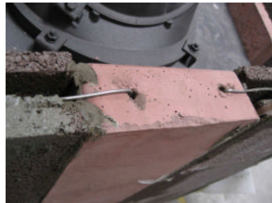
Danach wird der HMS Stein durch den Hafnerdraht mit den LilaTec-Steinen verbunden.
