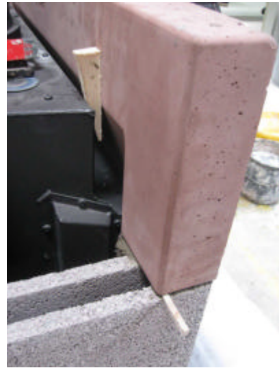
Nach dem Ausrichten, Sturz mit Holzkeile fixieren.
