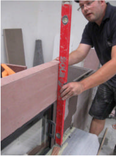
Sturz mit Wasserwaage ausrichten.
