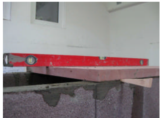
Deckelplatte ausrichten und mit Keile fixieren.
