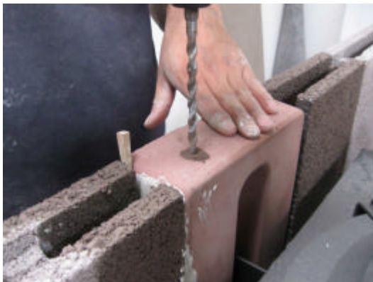
Mit einem Steinbohrer 1-2 cm tiefe Löcher in den HMS Stein bohren.
