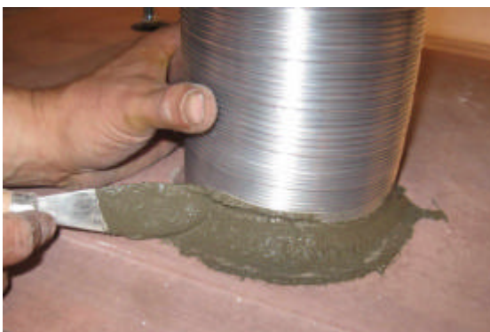
Flexschlauch mit Haftmörtel zuspachteln.
